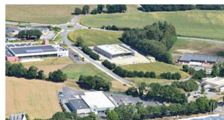
Vues aériennes de Pont Er Morh
