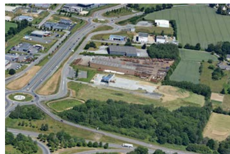
Vues aériennes du parc d'activités du Gohélève Sud
