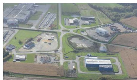
Vues aériennes du parc d'activités de Tréhonin
